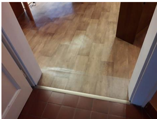
Odstranění dveřního prahu a zbroušení podlahy u učebny cizích jazyků
