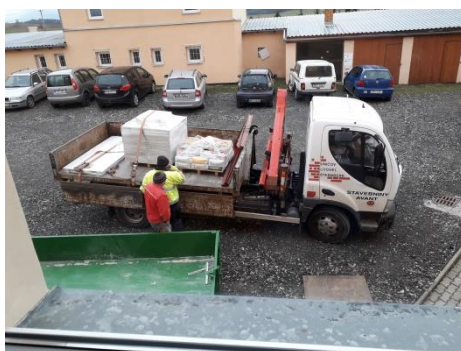
Dovoz materiálu na rekonstrukci WC
