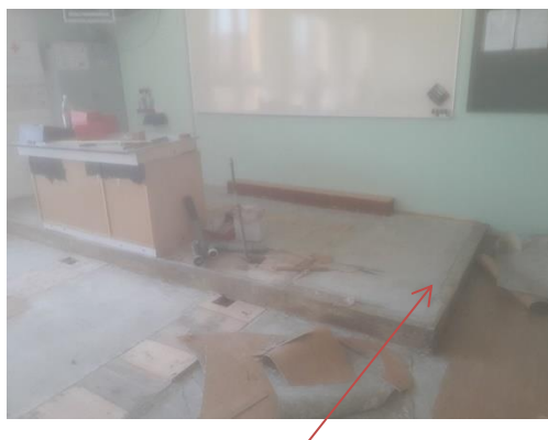
Původní stupínek při počátku modernizace
