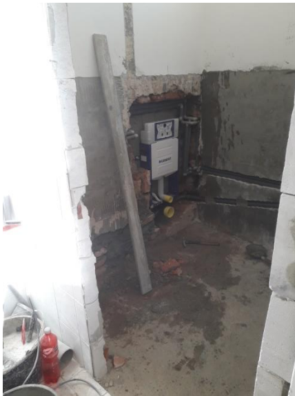
Stavební úpravy WC - vybourání původních příček, vysekání odpadů, obkladů
