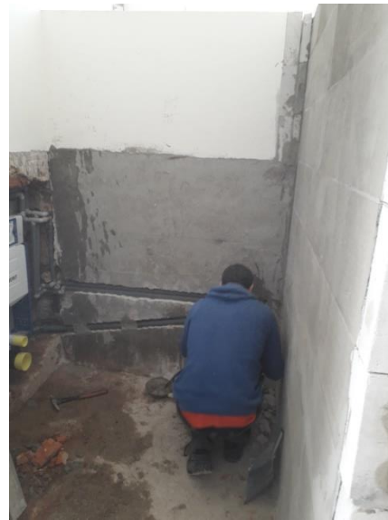
Stavební úpravy WC - vybourání původních příček, vysekání odpadů, obkladů
