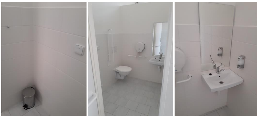
Pohled na konečný stav bezbariérové WC muži
