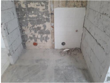
Stavební úpravy WC - vybourání původních příček, vysekání odpadů, obkladů
