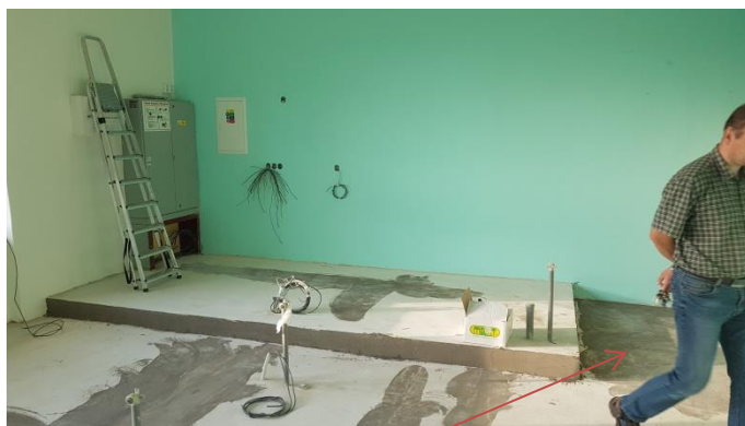
Odbourání části stupínku a vyspárování podlahy ke dveřím
