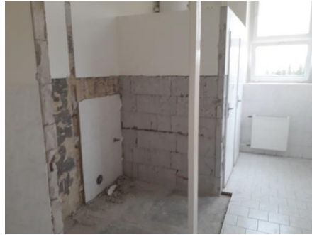
Stavební úpravy WC - vybourání původních příček, vysekání odpadů, obkladů
