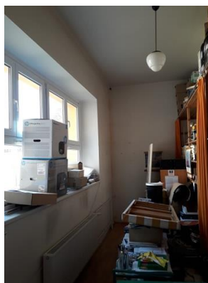
příprava prostoru pro instalaci serveru
