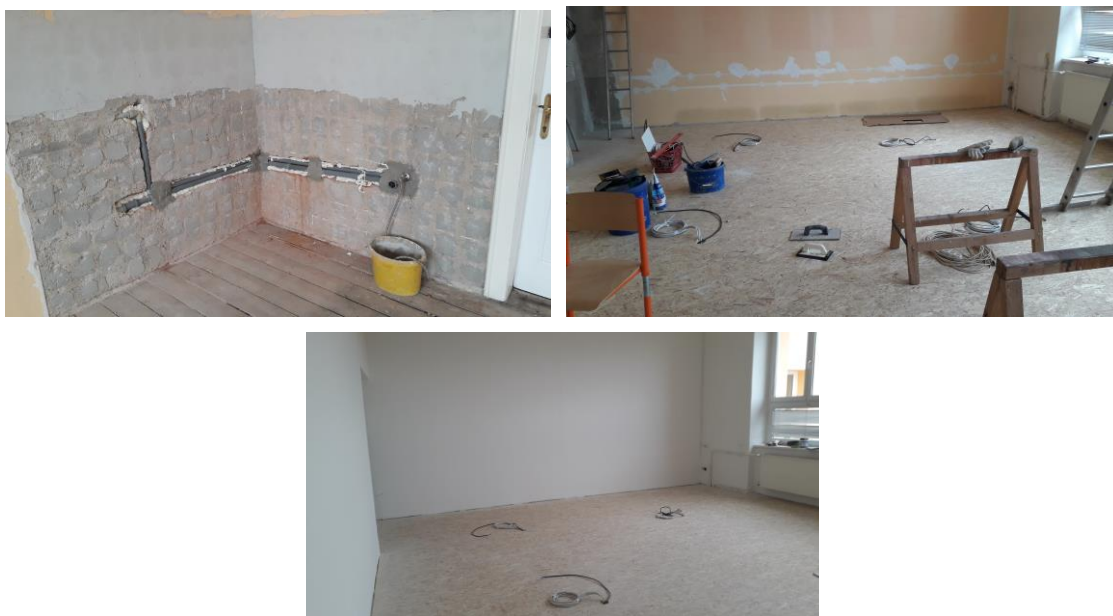
Stavební práce na učebně
